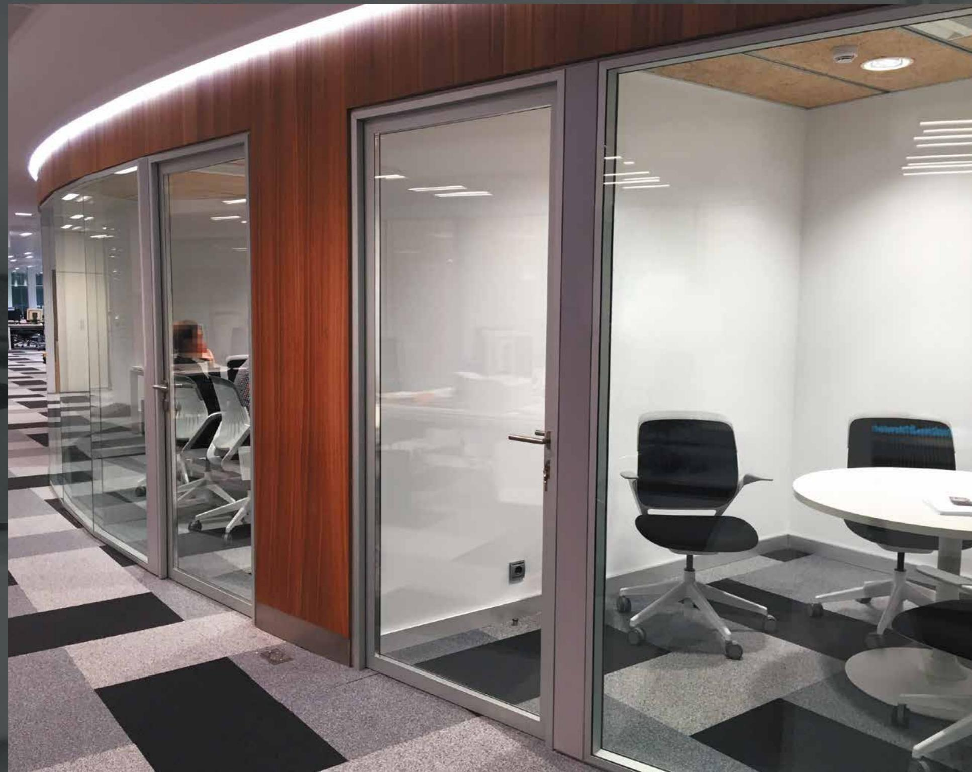
La opción de partición mixta ciego/vidrio oculta la colocación de mobiliario junto al muro y mantiene la luminosidad del ambiente.
